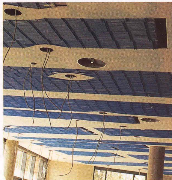
Clina - хол. потолки в штукатурке на гипс картоне
