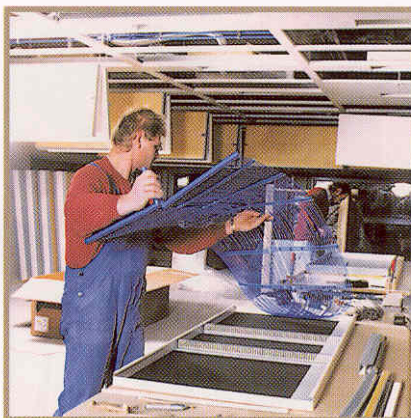
Clina маты фиксированы в металлических кассетах
