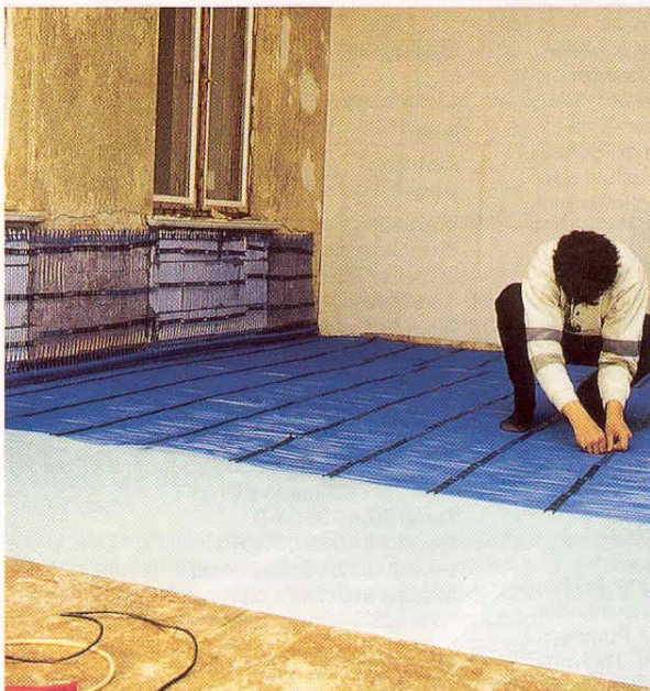
Обогрев полов при реконструкции старых зданий
